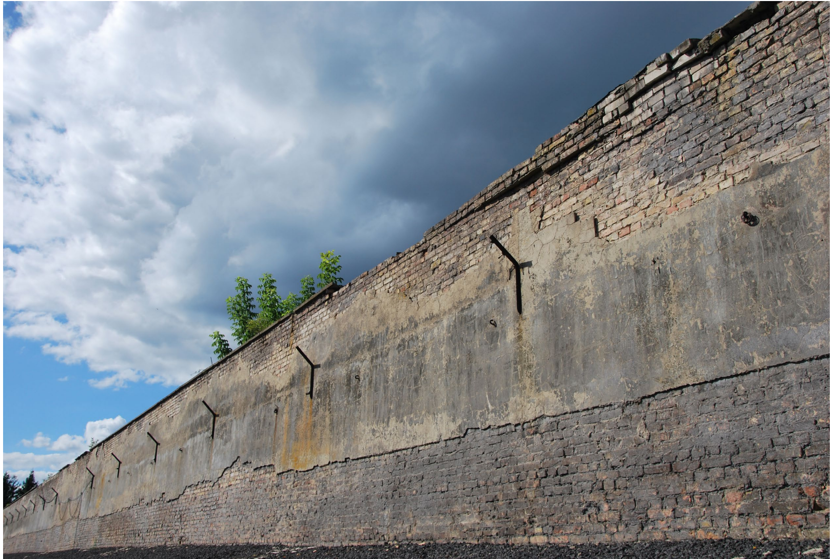
Ehemalige Lagermauer mit Halterungen für den elektrisch geladenen Stacheldraht in der Mahn- und Gedenkstätte Ravensbrück, August 2010.
